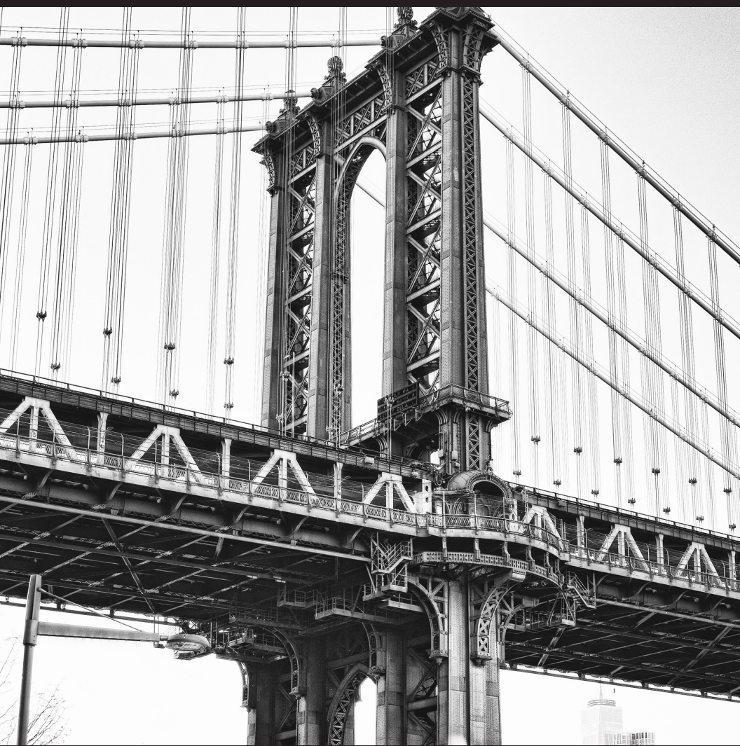
Puente de Manhattan, Nueva York, NY
