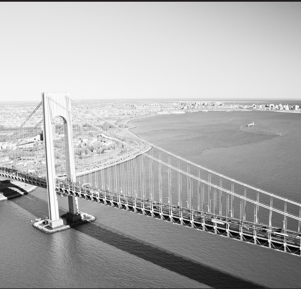
Puente de Verrazano-Narrows, Staten Island, NY
