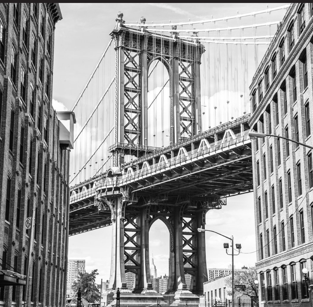
Puente de Manhattan, Nueva York, NY
